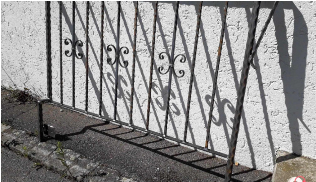
Metallbau schlosserei mast gmbh alle
