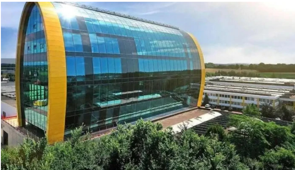
Windhorst stahl und metallbau gmbh goldenstedt
