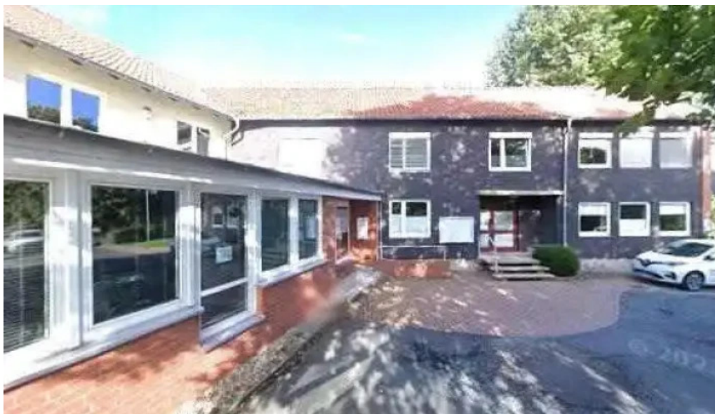
Samtgemeinde baddeckenstedt street view 360deg fotos
