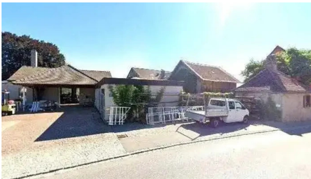
Wieser gmbh schlosserei und sanitäre anlagen street view 360deg fotos
