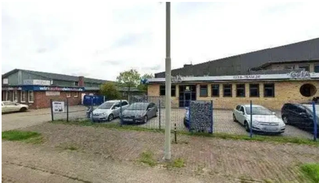
Gefa gmbh stahl und metallbau street view 360deg fotos
