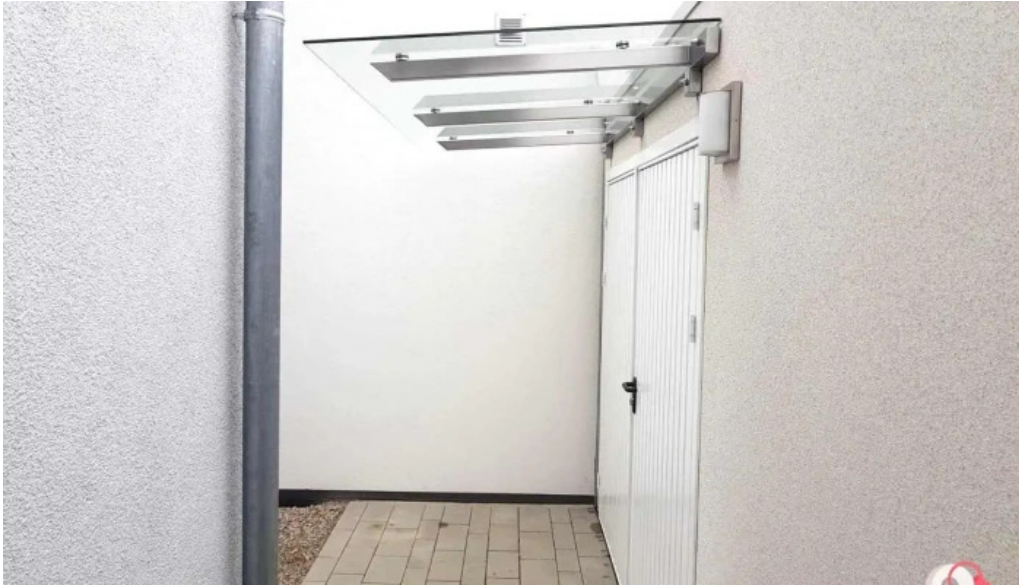
Metallbau bichert innenansichten
