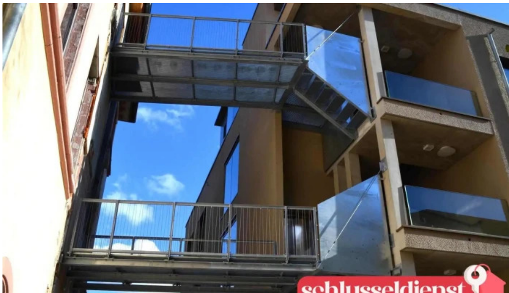
Schlosserei schneider gmbh aussenbereich
