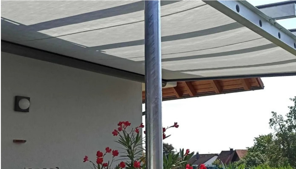
Schaible metallbau gmbh metallbauunternehmen
