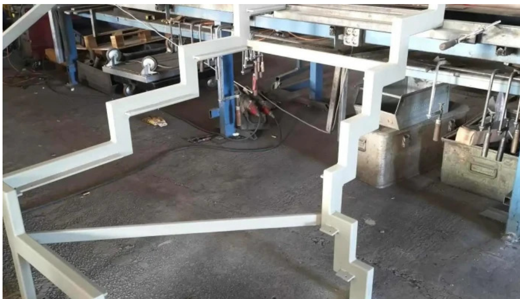
Andreas scalzo metallbau innenansichten
