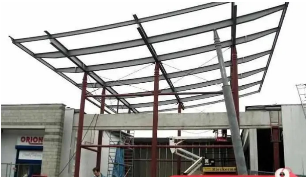
B s stahl und metallbau bendixen und schweda gmbh kiel alle
