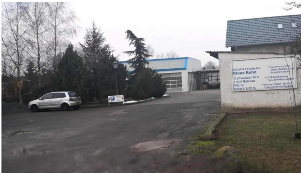
Metall fensterbau klaus kohn metallbauunternehmen
