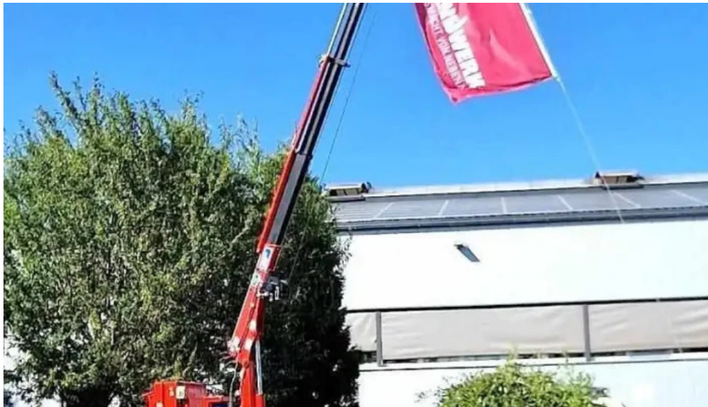
Metallbau becker gmbh gleichen
