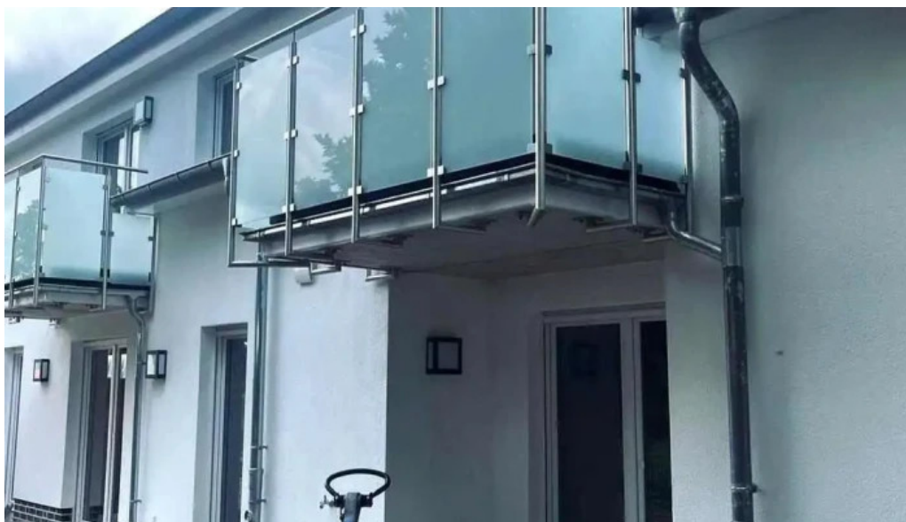
Top metallbau aussenbereich
