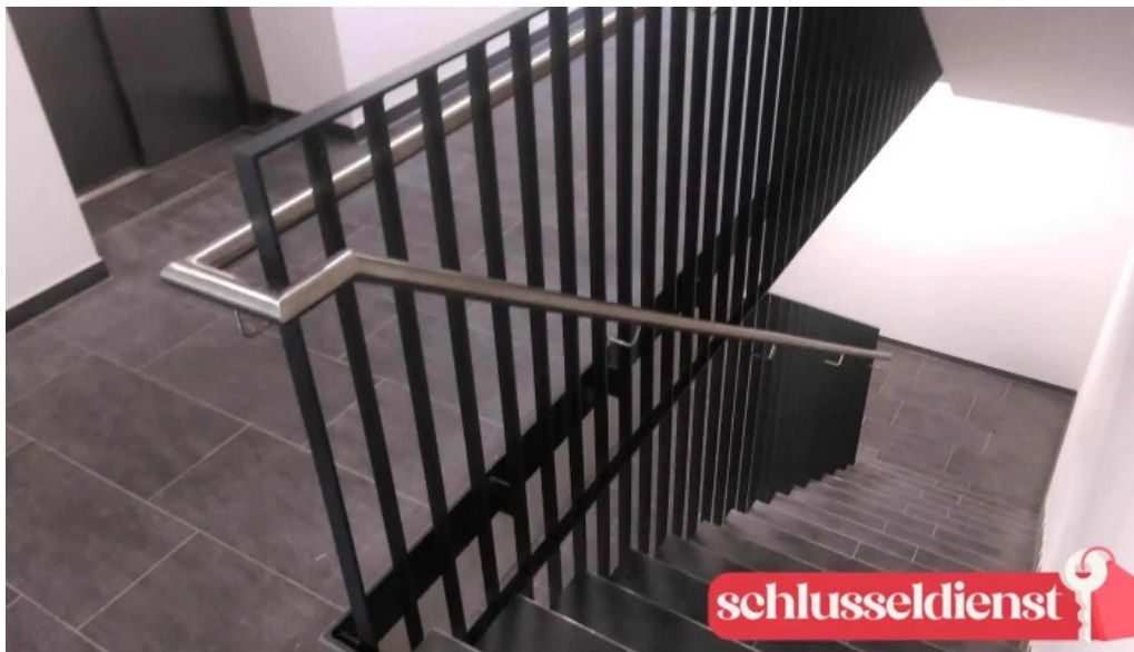
Zotzel stahl metall maschinenbau gmbh cokg alle
