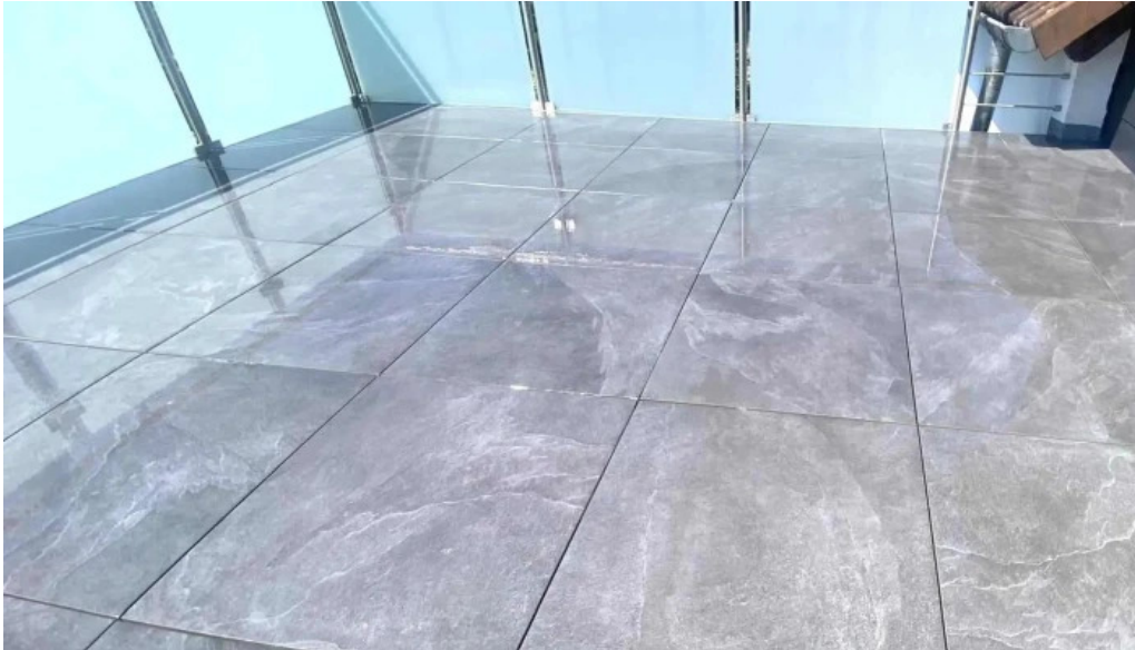
Weber edelstahlverarbeitung gmbh metallbauunternehmen
