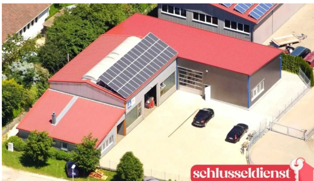
Abele stegmaier gmbh schlachtanlagen metallbau alle
