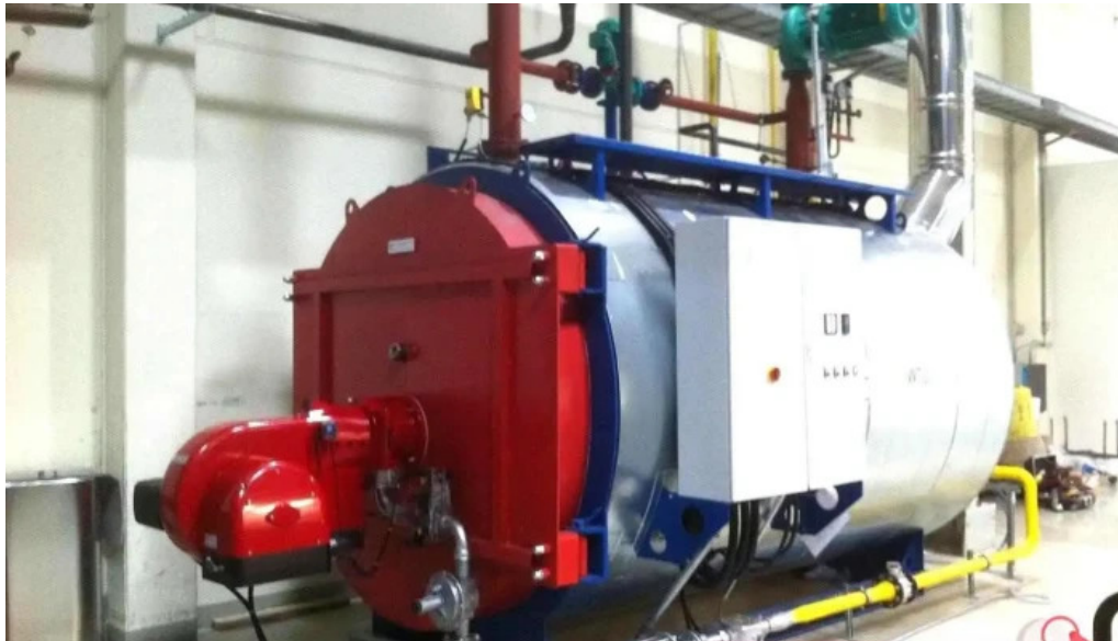
Iwts industrie wärmetechnik stocker u metallbau gmbh schwieberdingen
