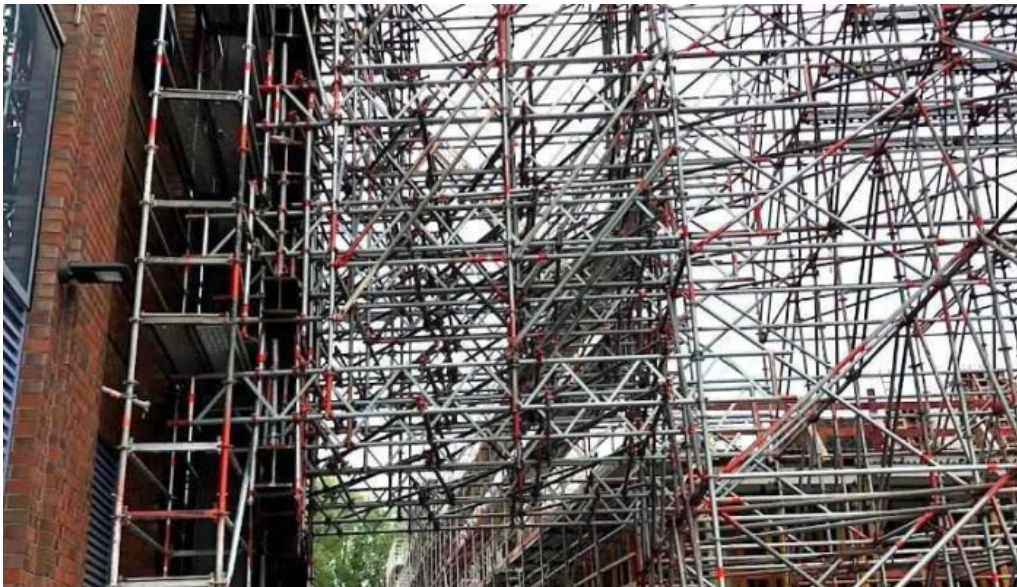
Eisenflechtereie und gerustbau jasari gmbh dassendorf
