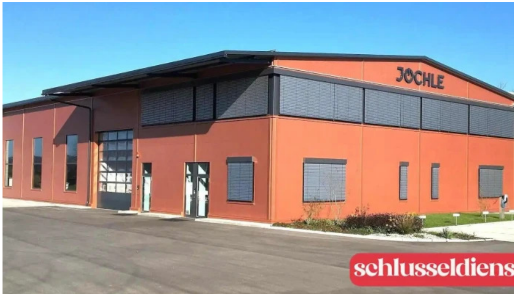
Jochle elektrotechnik gmbh bairdt
