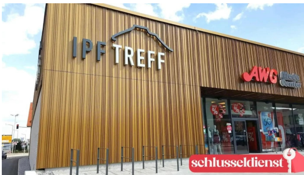
Mn metall gmbh aussenbereich
