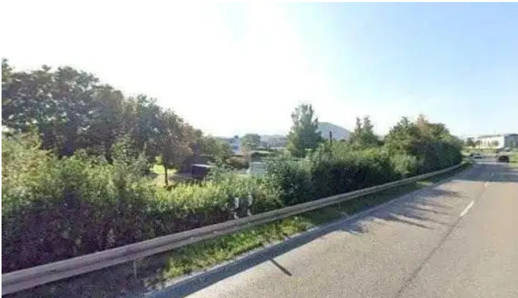
Bauhof street view 360deg fotos
