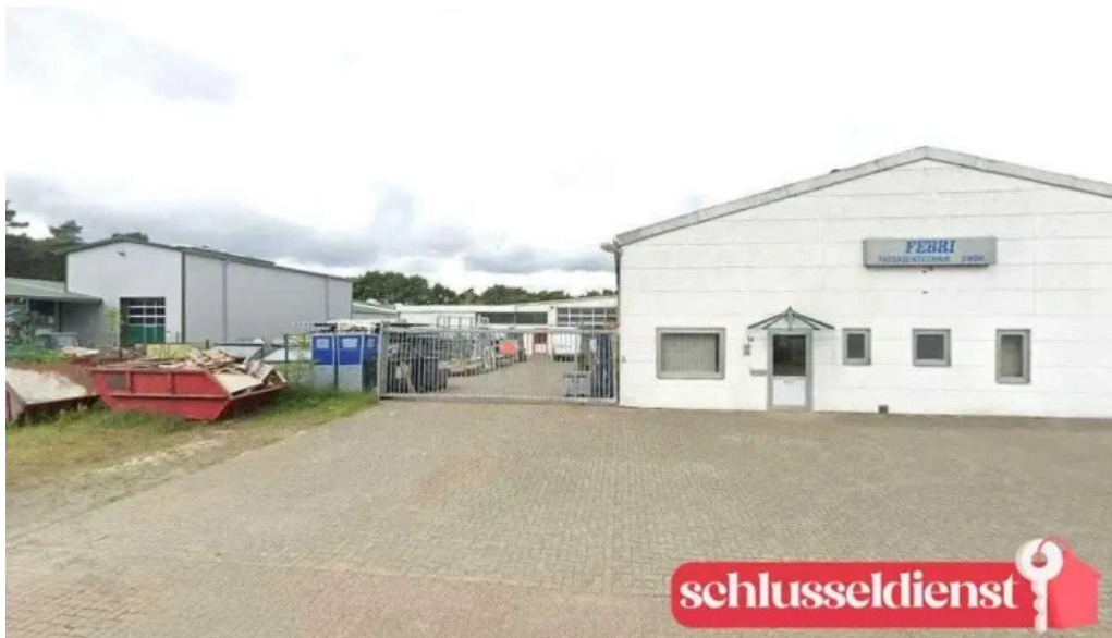
Febri fassadentechnik gmbh bosel
